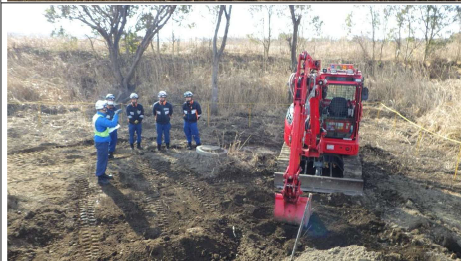
掘削・ 鋤取り訓練
